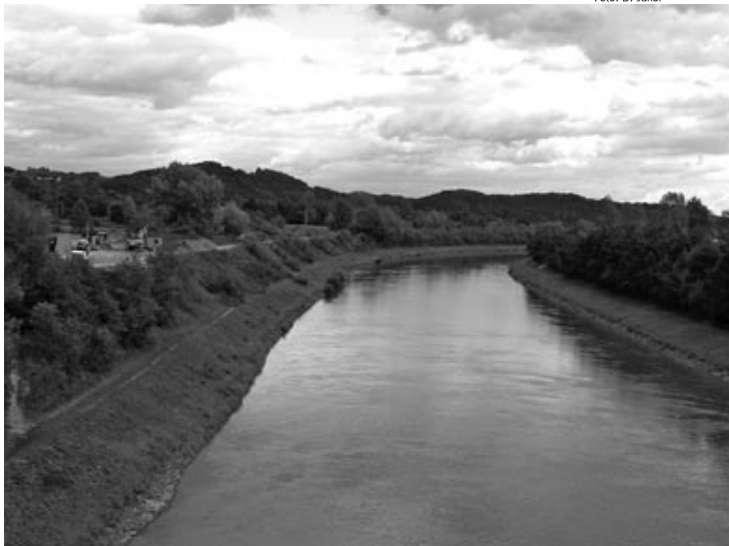
Odvodni kanal HE Zlatoličje Foto: D. Jákol
